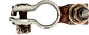
ボルトナット部分から発生した赤錆が本体に移行している。
